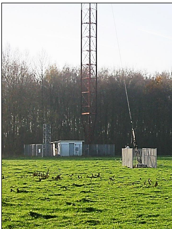
De voet van een mast en het bijhorende antennehuisje – foto WDR.
